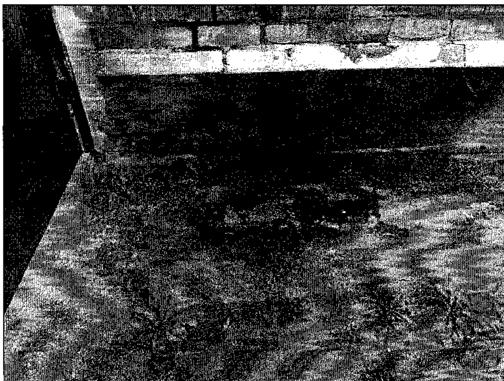
Фото 1, 2. Разрушение отмостки. Разрушение защитного штукатурного покрытия с поверхностной эрозией кирпичной кладки цоколя здания.
