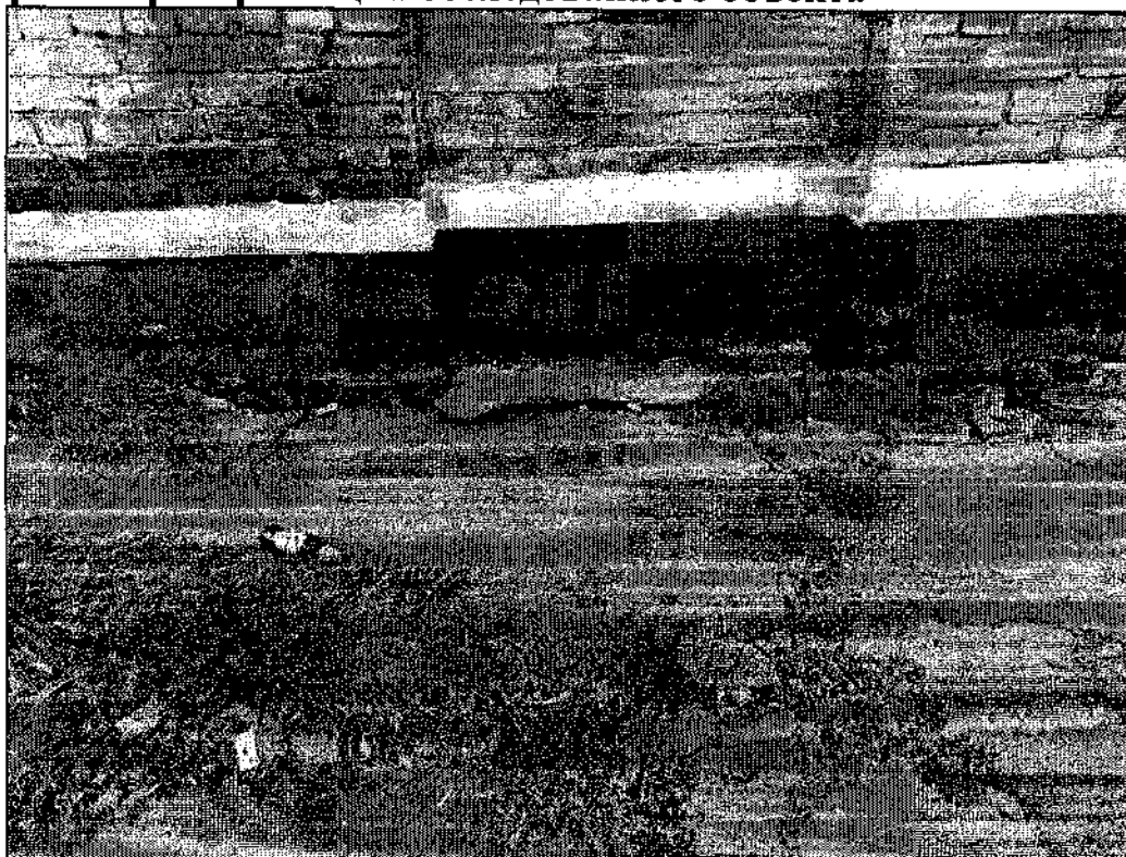
Фото 1, 2. Разрушение отмостки. Разрушение защитного штукатурного покрытия с поверхностной эрозией кирпичной кладки цоколя здания.
